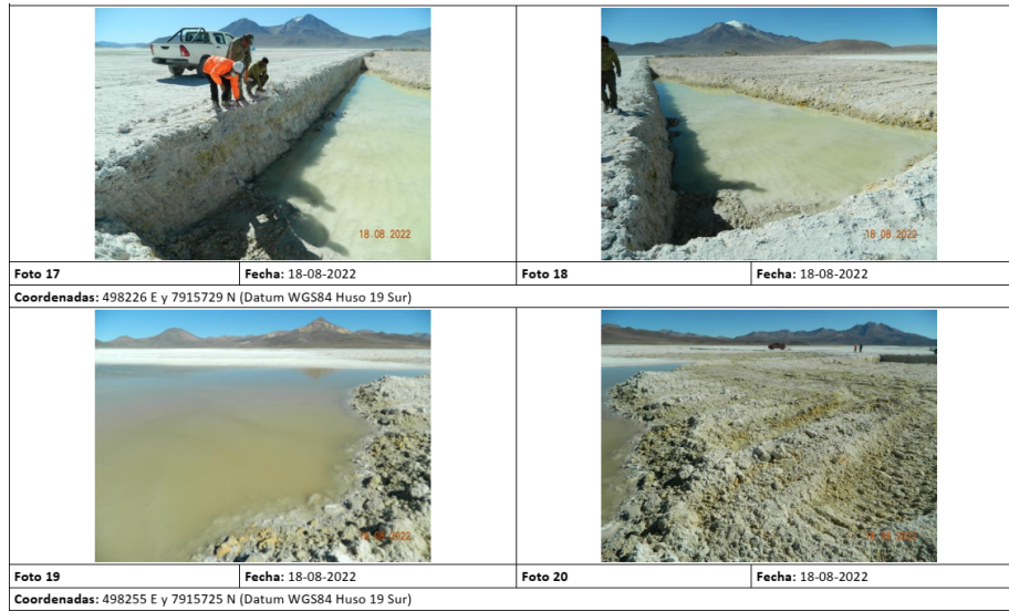
Imagen 16. Lagunas someras de origen artificial y frente de trabajo parcialmente inundado. Es posible apreciar los sedimentos completamente destruidos (granulados) 141 .
